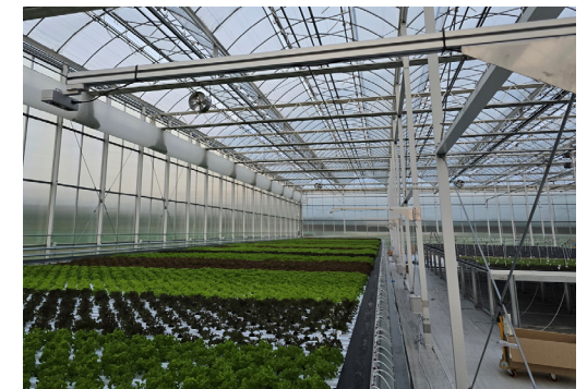
크로프트의 온실 모니터링 장비 설치 이미지 (사진 제공 : 크로프트)
